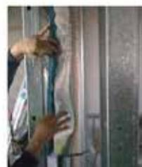
继续用推荐的搭接和接头处理对相邻管道区域进行隔音处理
