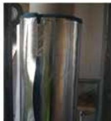
用小胶带固定包裹物，并将其牢固地固定在管道周围
